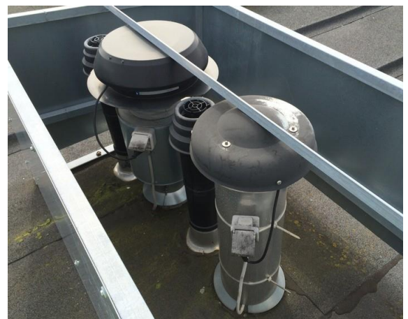
Der ses lidt forskellige typer af ventilatorer.
