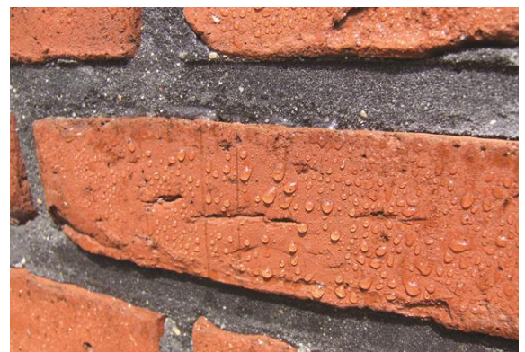
| Imprægnering af murværk.
