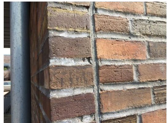
| Også fugerne i murværkets dilatationsfuger gennemgås og skiftes efter behov.
