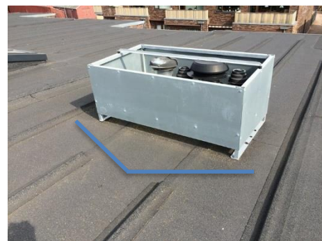
| Forslag om afvandingsrende foran rørgennemføringer.
