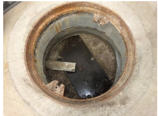
| Bagerste brønd i kælderen.
