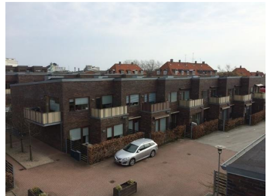
| Mange vinduer og døre.
